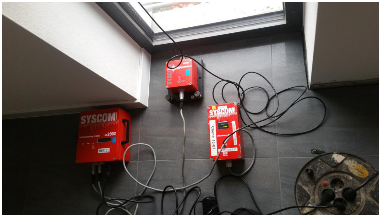
Bild 1: Blick auf das Erschütterungsmessgerät in der Messstelle M1
