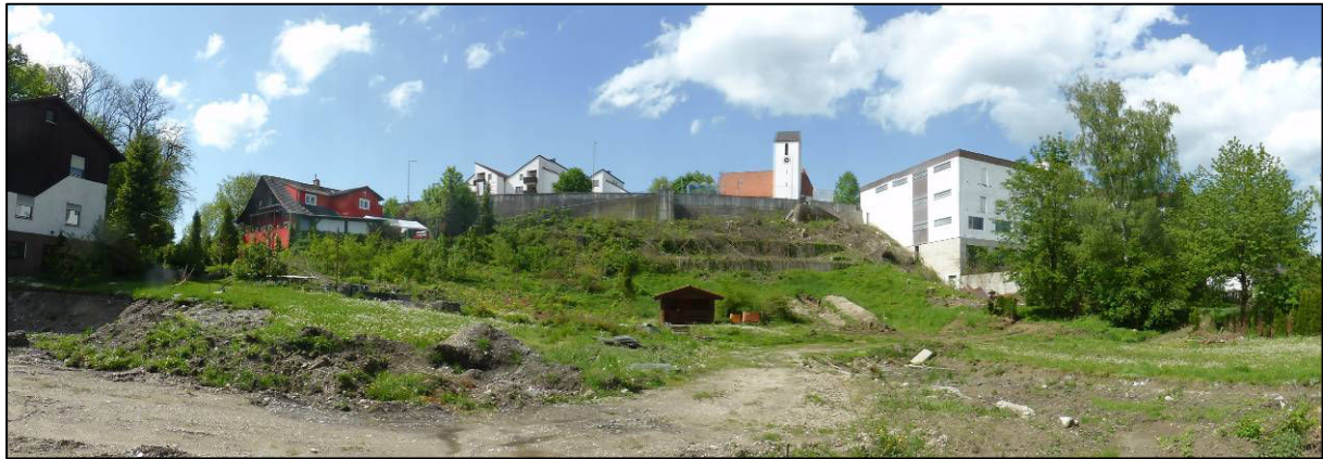
Abbildung 2 zentraler Geltungsbereich mit Blick nach Norden, zur Hauptstraße hin (Mai 2015)
